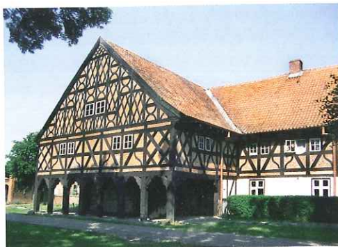
Dom podcieniowy w miejscowości Trutnowy na Żuławach stanowi przykład architektury wznoszonej przez ołędów. Charakterystyczny podcień ułatwiał rozładunek wozów, na których zwożono plony z pola lub siano.
