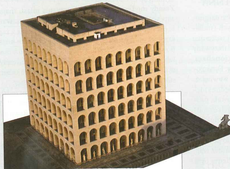
Pałac Cywilizacji Włoskiej w Rzymie, wzniesiony z rozkazu Mussoliniego, nazywany jest także kwadratowym koloseum. Budowla ta stanowi jeden z niewielu przykładów zaadaptowania stylistyki modernistycznej do zabudowy miast krajów totalitarnych.
