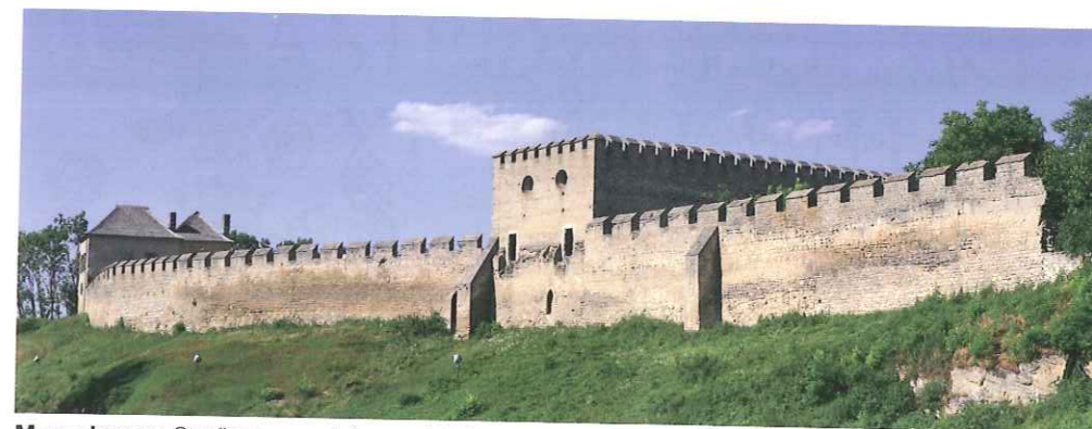
Mury obronne Szydłowa są zwieńczone blankami (krenelażem), czyli rzędem prostokątnych elementów przypominających zęby. Prześwity między nimi ułatwiały prowadzenie obrony miast – m.in. umożliwiały łucznikom ostrzał przeciwników.
